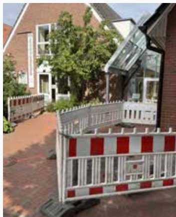
Zwischenzeitlich war der Haupteingang des Salzhäuser Gemeindehauses nur schwer zugänglich. Inzwischen ist die Fernwärme installiert und beheizt nun von der Biogasanlage aus die Räume.
